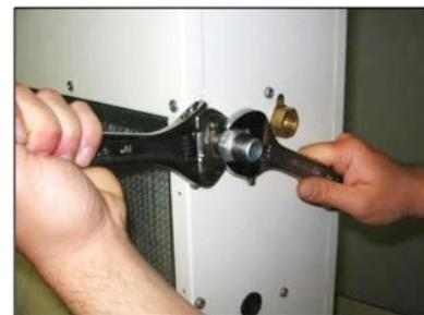
Raccordare le tubazioni tramite giunti flessibili al fine di evitare la trasmissione di vibrazioni e compensare le dilatazioni termiche.
