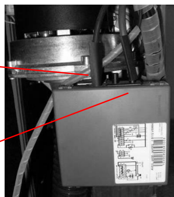
Elettrodi accensione/rilevazione
