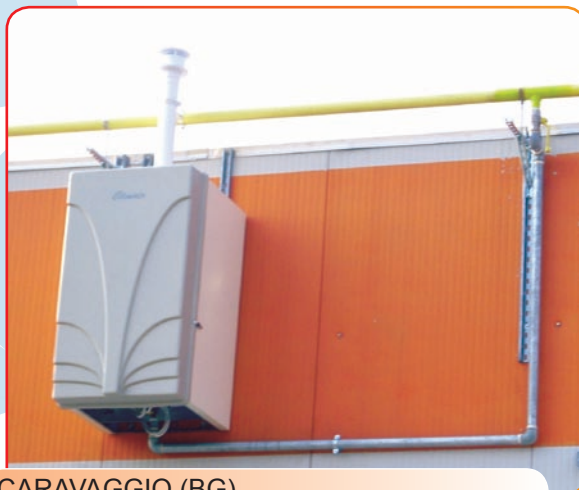
CARAVAGGIO (BG), Vivaio capannoni e serre n° 18 Climair 70 e Leaderjet 70 canalizzati portata termica totale: 1260 kW
