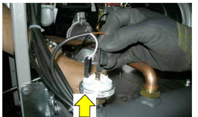
- Rimuovere la connessione pressostato gas.
