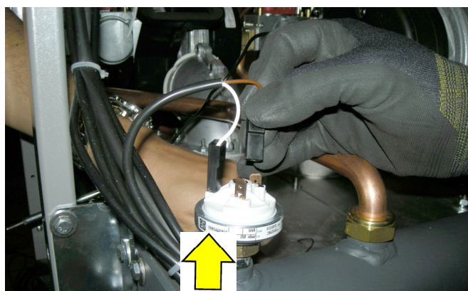
- Rimuovere la connessione pressostato gas.
