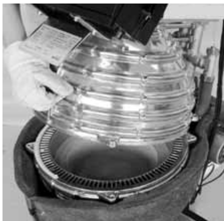
Fig. 5-4 Ribaltamento della copertura
