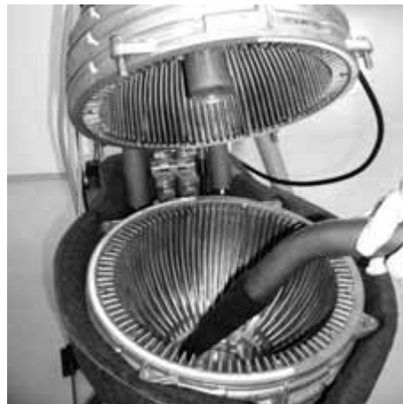
Fig. 5-7 Pulizia della camera di combustione
