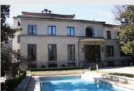
COPERTURA RADIANTE STRUTTURA SPORTIVA E CASA MUSEO VILLA NECCHI MILANO
