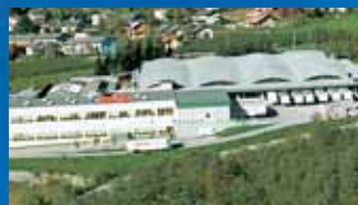
Stabilimento di Scurelle (I) finestre e vetrocamera
