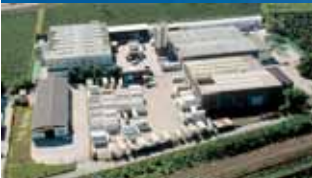
Stabilimento di Cortaccia (I) profilati e finestre
