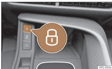
Fig. 76 Nella console centrale: pulsante della chiusura centralizzata
