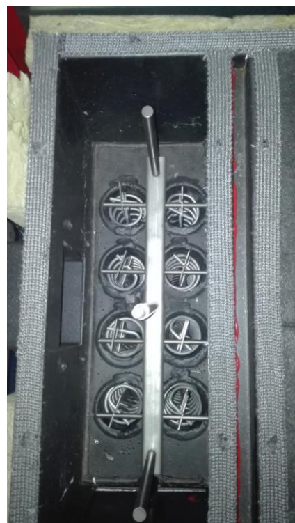
Sistema raschiatori e turbolatori
