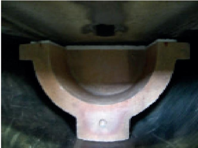
Quando si sono tolte entrambe le pietre, usando un aspiratore, rimuovere le ceneri presenti alla base dei tubi fumo. Prima di eseguire questa operazione azionare per una decina di volte la leva di scuotimento, che permette la pulizia dei tubi fumo tramite i turbolatori della caldaia. Sempre con il bidone aspiratore, rimuovere la cenere depositata sulla testa della sonda Lambda.
