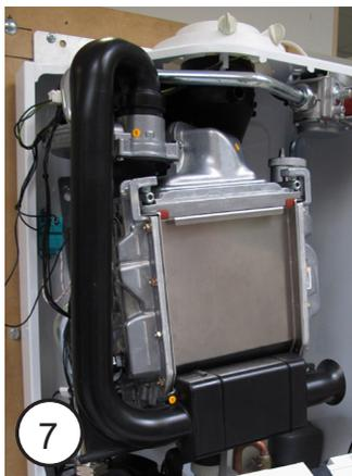
7. Aprire il mantello della caldaia e l'unità di controllo;
