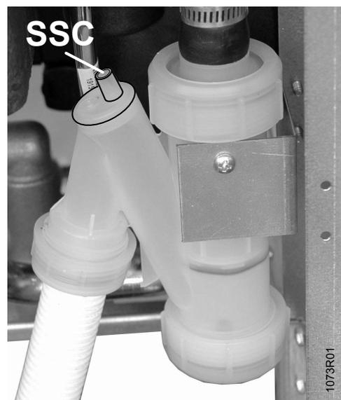
**⚠** **Controllare la tenuta del sifone, verificando che entrambi i tappi (superiore ed inferiore) siano correttamente e completamente avvitati.**
