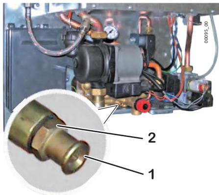
**(i)** Nello scambiatore primario resta un certo quantitativo d'acqua dell'impianto di riscaldamento. Se intendete rimuovere la caldaia dalla parete, consigliamo di chiudere, con dei tappi, gli attacchi idraulici di mandata e ritorno impianto riscaldamento.
