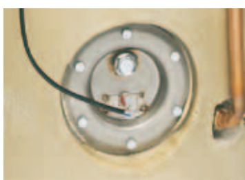
Flangia d'ispezione bollitore anteriore di facile accessibilità
