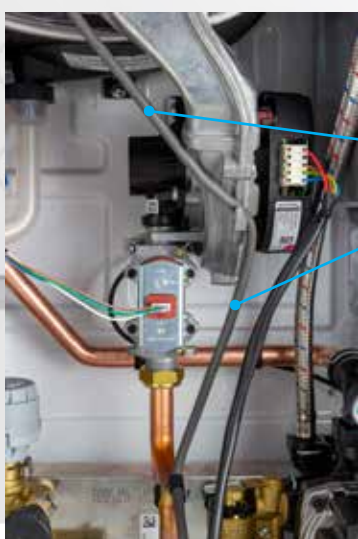
Cavo candela di accensione distanziato per evitare radiodisturbi
