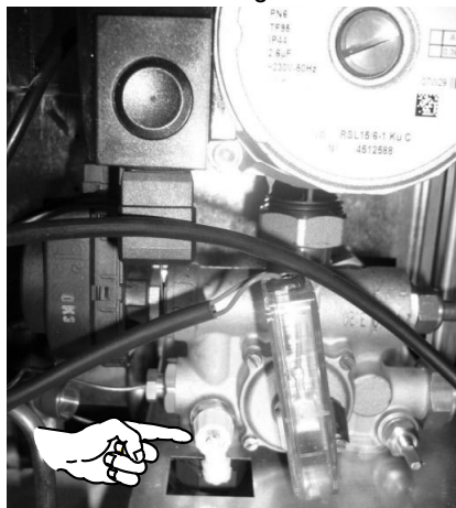
Figura 9.7 Rubinetto di svuotamento circuito primario.
