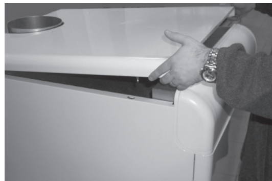
Fig. 4 - Ejercer presión de abajo hacia arriba para levantar la tapa que está retenida en los costados de la caldera mediante clavijas de inserción.
