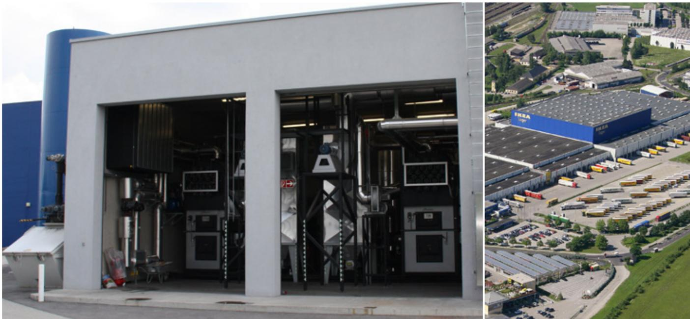
Il nome Ikea non ha bisogno di presentazioni. La tecnica Froling fornisce calore a molte sue sedi. Presso il magazzino centrale di Wels, due caldaie da 1.000 kW con combustibile pellet coprono l'intero fabbisogno termico.
