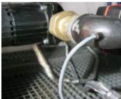
Sonda temperatura per i sistemi ausiliari di riscaldamento (puffer o accumulatori) Temperature probe for auxiliary heating systems (puffer or accumulators) Sonde de température pour les systèmes de chauffage auxiliaires (pompe ou accumulateurs) Temperaturfühler für Zuheizung (Kugelfisch oder Akkumulatoren) Sonda de temperatura para sistemas de calefacción auxiliares (pez globo o acumuladores) Αισθητήρα θερμοκρασίας για βοηθητικά συστήματα θέρμανσης (puffer ή συσσωρευτές)
