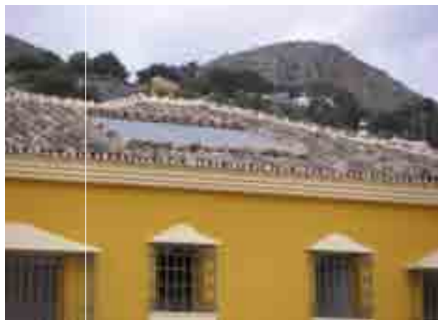
Esempio di installazione Pannelli Piani integrati nel tetto inclinato Example
