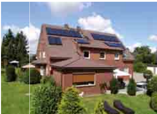
Esempio di installazione Pannelli Piani su tetto inclinato in serie e parallelo Example
