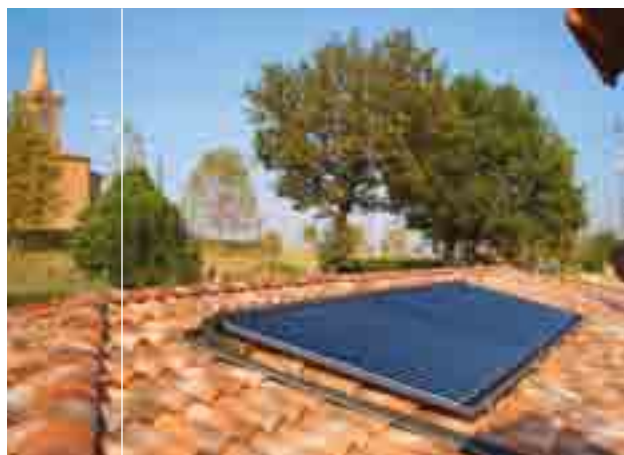
Esempio di installazione Pannelli Sottovuoto su tetto inclinato in serie Example
