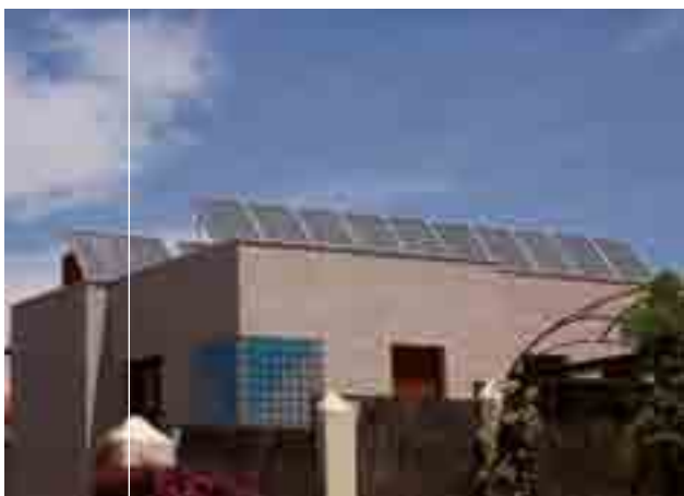
Esempio di installazione Pannelli Piani su tetto piano in serie e parallelo Example
