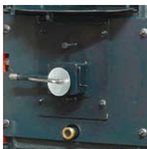
Modulatore aria comburente Air combustion modulator
