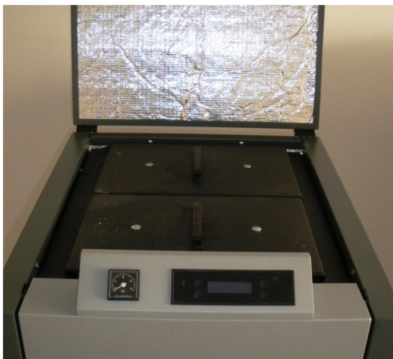
Figura 7.3.5 Entrambi i coperchi di convogliamento dei gas di combustione vengono posizionati sullo scambiatore di calore della caldaia per acqua calda.
