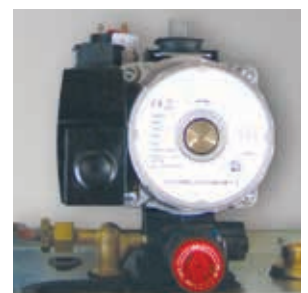
Motore pompa con disaeratore incorporato
