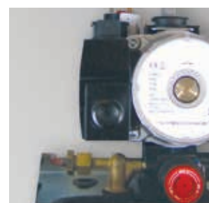
Motore pompa con disaeratore incorporato
