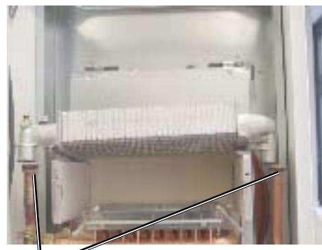
Smontare i fermagli di fermo [10]
