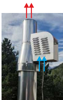
Montato su tubo a doppia parete inox
