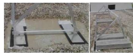
Base per stabilizzazione del telaio tramite calcestruzzo
