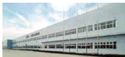
Fujitsu General Central Condizionatore d'aria (Wuxi) Co., Ltd. (Cina).
