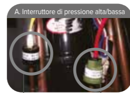
Interruttore di pressione bassa pressione Interruttore di pressione alta pressione
