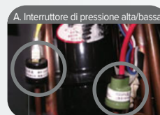
Interruttore di pressione bassa pressione
