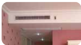
Flusso d'aria frontale, entrata aria frontale
