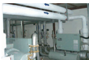
Pompa di calore Water Source concezione tradizionale installata in una centrale termica
