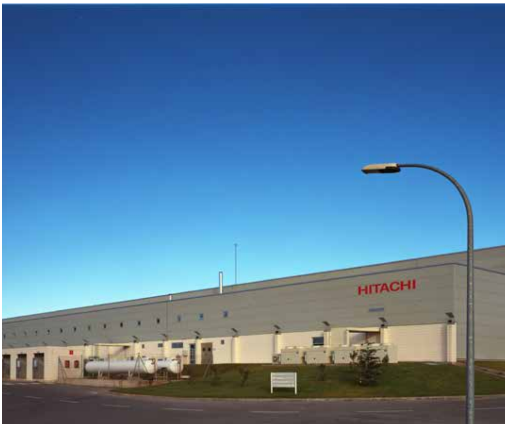
Hitachi Air Conditioning Products Europe - Stabilimento HAPE - Barcellona, Spagna
