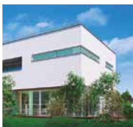
Smart House. Ariake, Tokyo. HVAC in combinazione con la produzione di energia solare, celle a combustibile e batterie di immagazzinamento dell'energia.
