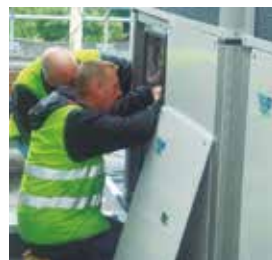
The National Grid's. Ristrutturazione Call Center. Hinkley, GB. ECO G
