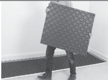
Posare i singoli elementi da sinistra verso destra
