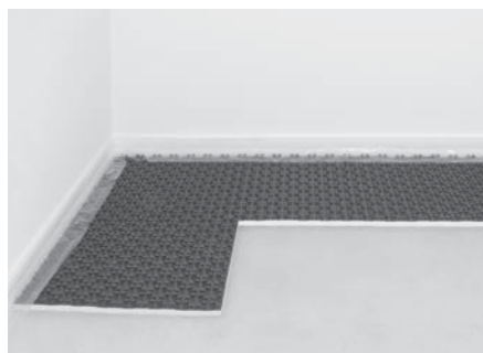
Iniziare la fila di pannelli successiva con gli sfridi ricavati dagli altri pannelli.
