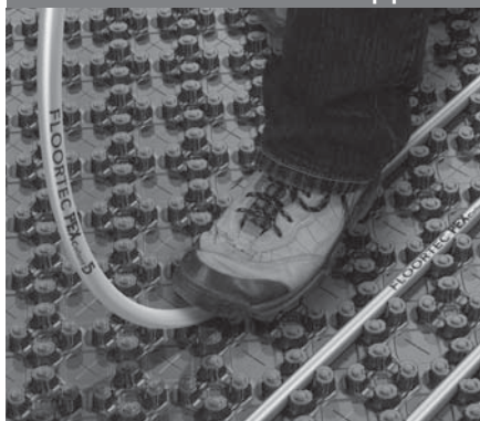
Fig. 1: Posa dei tubi Pe-Xcellent a 5 strati 14 x 2 mm
