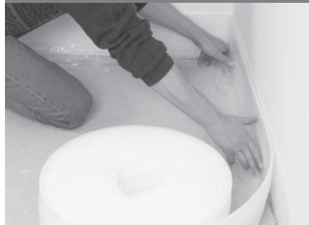
Applicare il nastro di isolamento perimetrale munito di apposita pellicola laterale.
