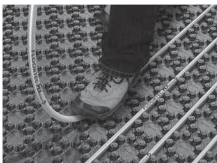
Fissare il tubo fra le bugne, calpestabili, passandoci sopra con il piede. Tubo: per riscaldamento a pavimento Pe-Xcellent a 5 strati (14 x 2 mm, 17 x 2 mm), flessibile e facile da posare, o quello multistrato (16 x 2) fra le bugne calpestabili passandoci sopra con il piede.
