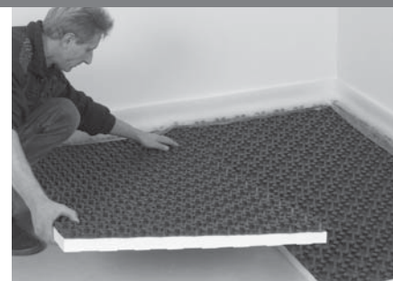
Fig. 1: Posa dei pannelli
