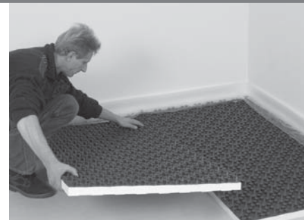
Fissare i pannelli del sistema Noppen FLOORTEC
