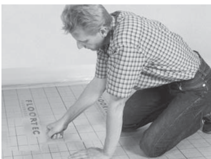
I rotoli di isolamento sovrapposti e muniti di autoadesivo di 3 cm
