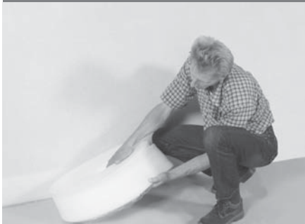
Fissare il nastro di isolamento perimetrale con pellicola laterale
