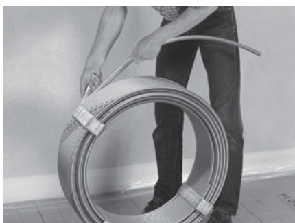
Fissare l'impianto di tubi Tacker sui pannelli del sistema...
