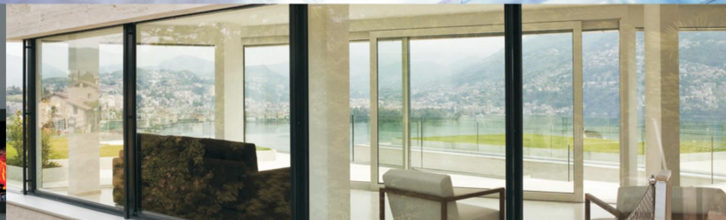
L'eliminazione dei rinforzi d'acciaio migliora notevolmente i parametri termici e limita le perdite di calore. Una superficie del telaio più snella permette di sfruttare meglio l'energia solare e garantisce l'aumento della luce naturale nelle camere. L'incollaggio del vetro con il profilo aumenta la stabilità della finestra stessa.
