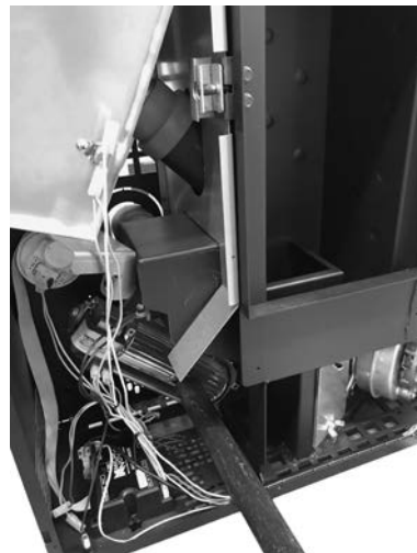
Fig. 69 - Pulizia ventilatore ambiente
