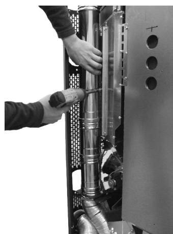
Fig. 64 - Fissaggio tubo
