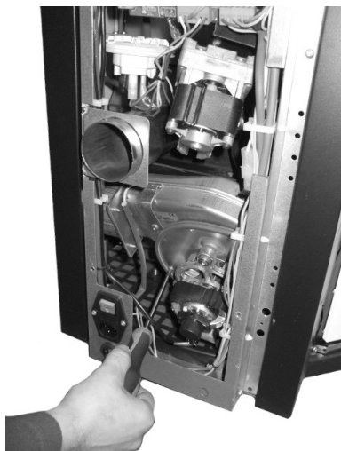
Fig. 104 - Pulizia aspiratore fumi: fase 1
