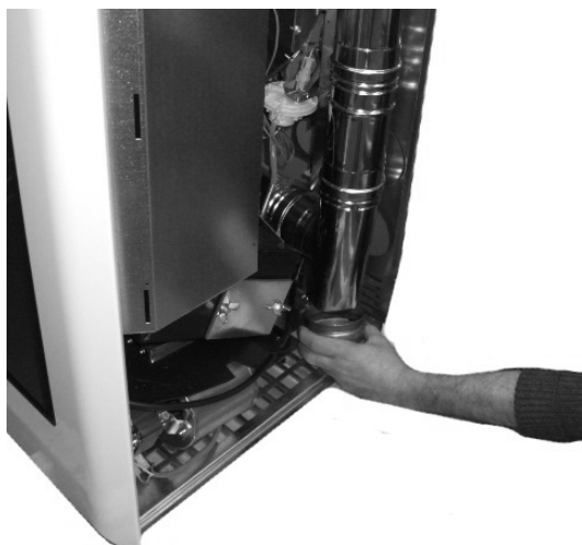
Fig. 102 - Pulizia canale da fumo
