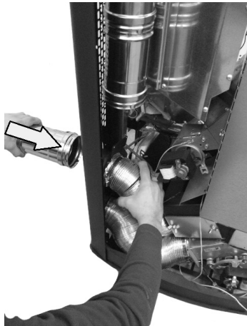
Fig. 66 - Posizionamento tubi per canalizzazione
