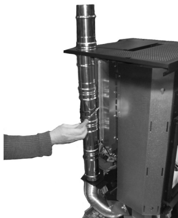
Fig. 56 - Posizionamento tubi per canalizzazione superiore
