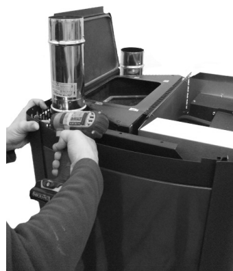
Fig. 47 - Riposizionamento profili curvi superiori
