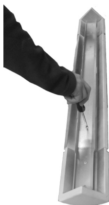
Fig. 34 - Avvitare profilo alle maioliche
