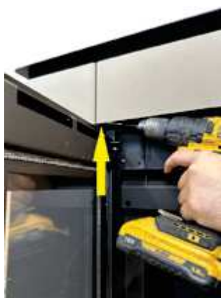
Fig. 32 - Rimuovere la vite di sicurezza
