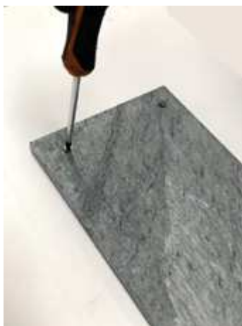
Fig. 21 - Avvitare viti
