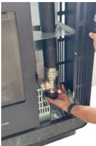
Fig. 65 - Pulizia canale da fumo
