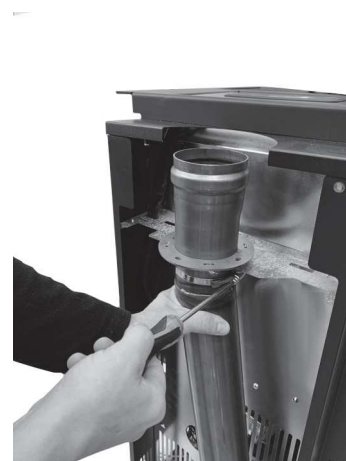
Fig. 42 - Bloccare con fascetta
