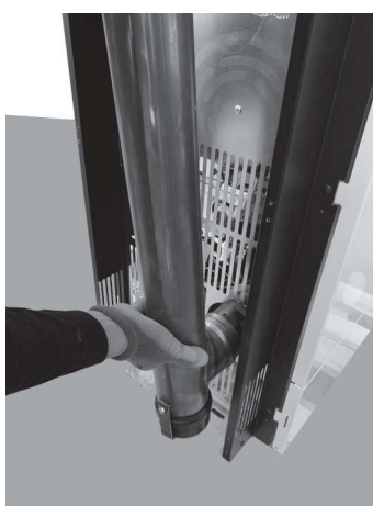
Fig. 41 - Innestare tubo d.80 mm
