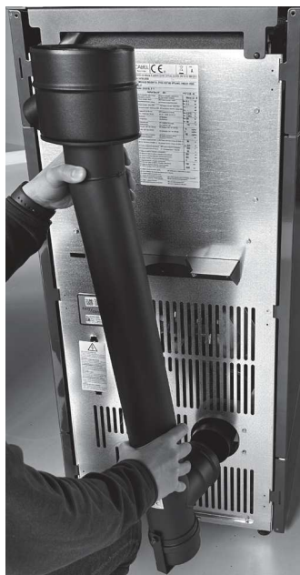
Fig. 56 - Kit scarico fumi superiore con concentrico
