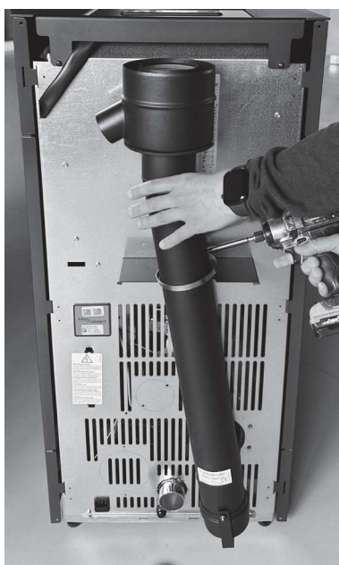
Fig. 57 - Innestare tubo d.80 mm
