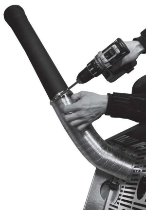
Fig. 67 - Collegare tubo d.80 mm
