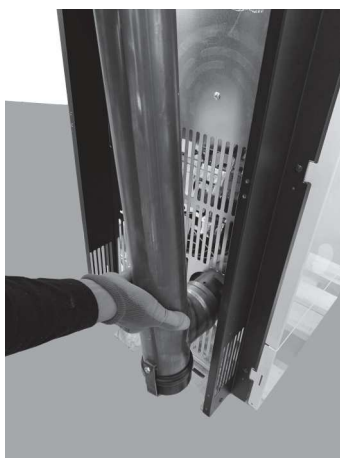
Fig. 47 - Innestare tubo d.80 mm
