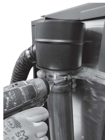
Fig. 48 - Bloccare con fascetta
